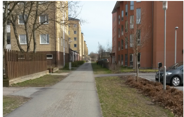
Figur 1. Gång- och cykelväg i riktning mot skolan genom området Nyby centrum som uppfördes på 70-talet.
