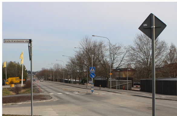
Figur 10. Passage över Iduns väg i höjd med Greta Arwidssons väg. Gatan är nyligen ombyggd men hastighetsdämpande utformning saknas.
